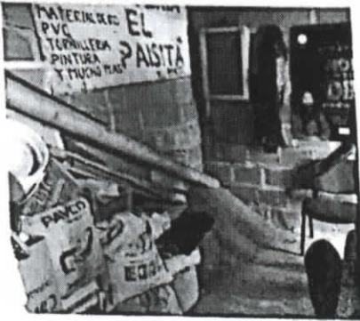
Fotografía No 1. Materiales al interior del predio con dirección Calle 18 # 28 - 55.
