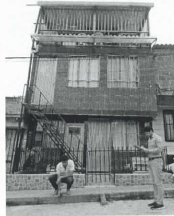
Foto No. 3 Fachada actual
