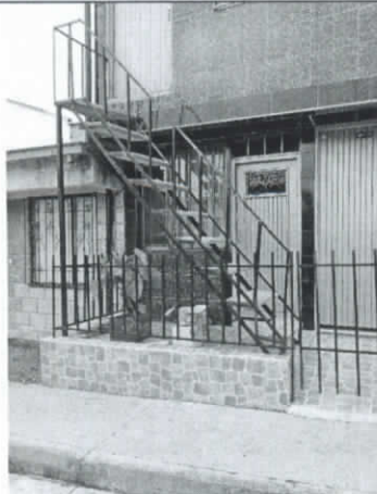
Foto No. 5 Escaleras
