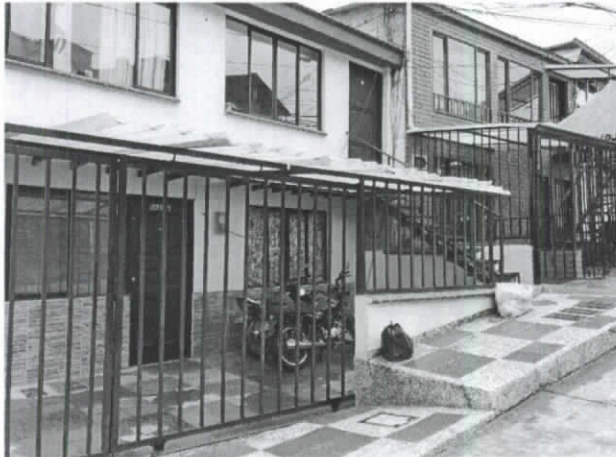
Foto No 6. Escaleras, cerramiento y cubierta sobre antejardín.
