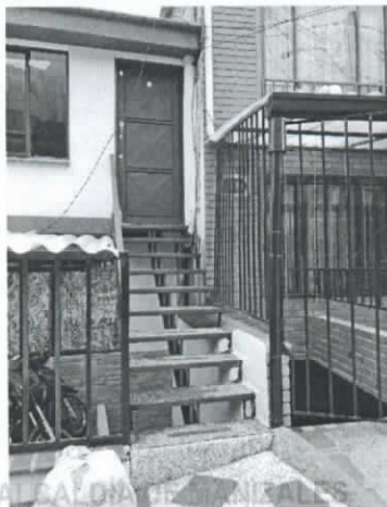
Foto No 4. Escaleras, cerramiento y cubierta sobre antejardín
