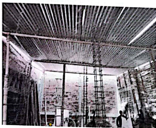
Foto No 4. Cubierta en teja en teja de zinc apoyada en guaduas.
