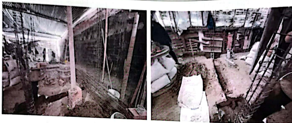
Foto No 3. Material de obra al interior del lote, fundida de zapatas en concreto y acero de refuerzo para continuar con la fundida de las columnas.
