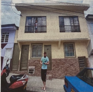
Foto No. 1 Fachada de la vivienda.
