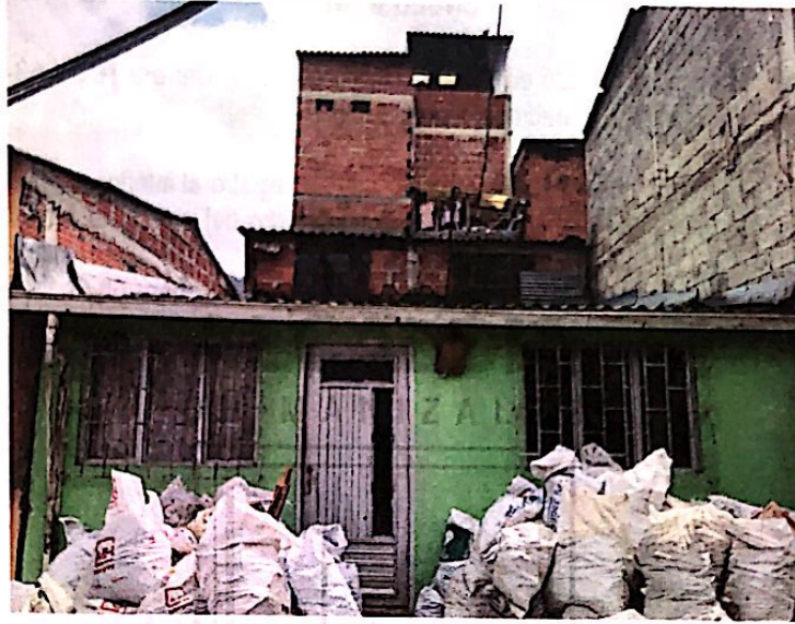
Foto No. 1 Fachada de la vivienda.
