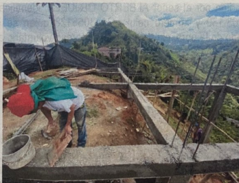
Foto No. 3 Columnas y vigas en concreto para la construcción de un peladero de café.
