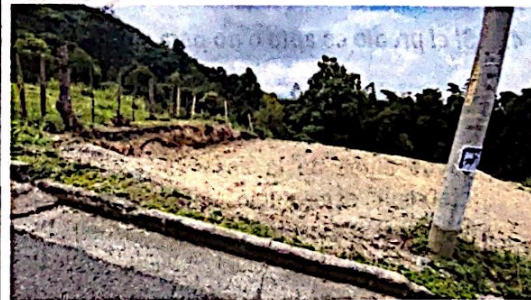
Foto No. 2 Movimiento de tierras en proceso.
