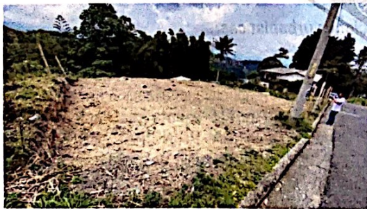
Foto No. 1 Movimiento de tierras en proceso.
