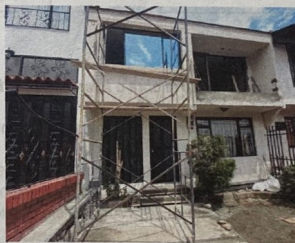
Foto No. 2 Resane y pintura de fachada principal.
