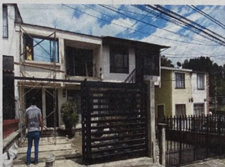
Foto No. 1 Fachada de la vivienda
