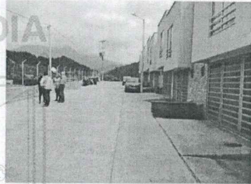
Foto 2. Vía No. 1 Tramo norte
