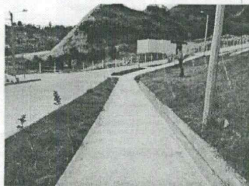
Foto 10. Andenes en buen estado Vía No.2 Tramo sur
