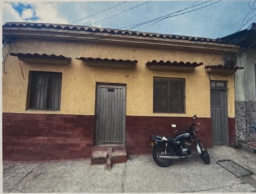
Foto No. 1 Fachada de la vivienda ubicada en Calle 38 # 27-14
