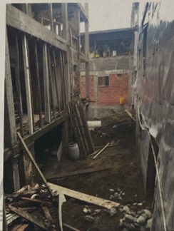
Foto No. 6. Imagen de la construcción, materiales, y escombros.
