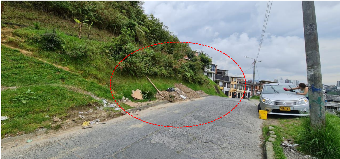
Fotografía No 1. Acopio de escombros sobre el espacio público en la dirección Calle 55 con Carrera 9A enseguida lavadero.
