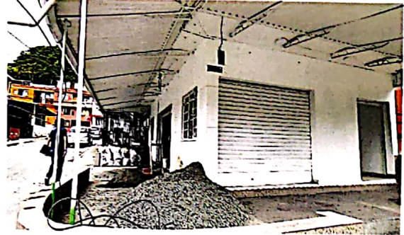
Foto No 8. Detalle de la cubierta internamente, también se observan los apoyos
