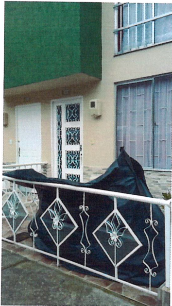
Fotografía No 1. Fachada actual de la vivienda, se observa reja metálica y losa de contrapiso en el antejardín
