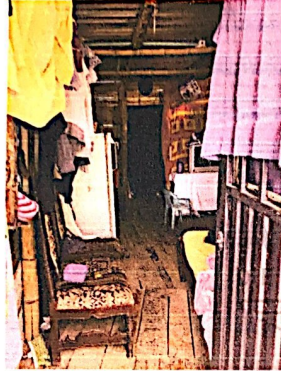
Foto No. 3 Vivienda en estructura de guadua con cerramiento en esterilla.
