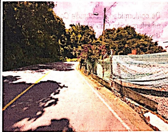
Foto No. 2 Lugar de la intervención.
