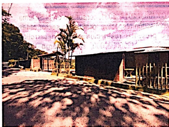
Foto No. 1 Fachada de la construcción.
