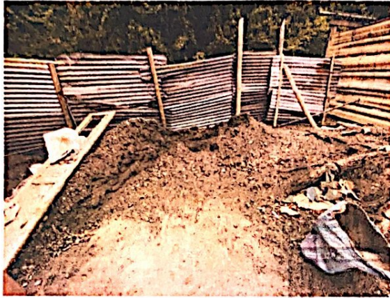
Foto No. 3 Material de construcción.
