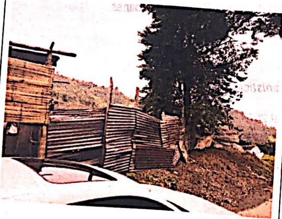
Foto No. 1 Fachada de la construcción.
