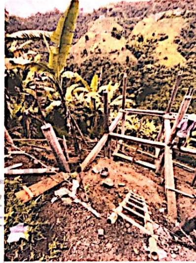
Foto No. 4 Personal adelantando labores de construcción.
