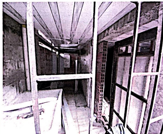
Foto No. 4. Construcción en curso.
