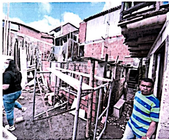
Foto No. 2 Personal adelantando labores de construcción
