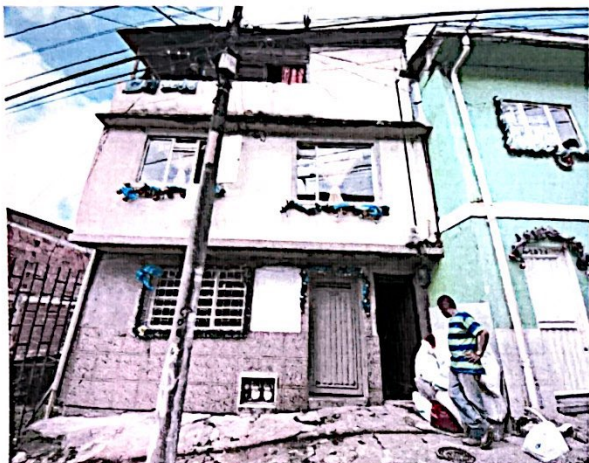
Foto No. 1 Fachada de la vivienda en construcción.
