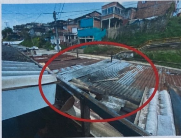
Foto No. 4. Estructura metálica para adecuar la cubierta.
