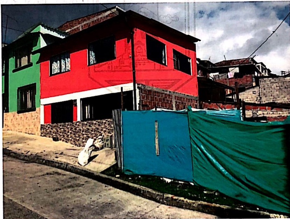
Fotografía No 3. Fachada de la vivienda con dirección Calle 40 No. 16-94
