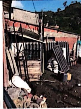
Fotografía No 2. Al momento de la visita se evidenció material de construcción al interior del inmueble.
