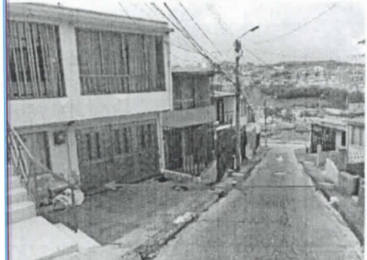
Foto No. 6 Perfil de vía tomado en sitio antejardín 2,30 m, circulación 0,70 m
