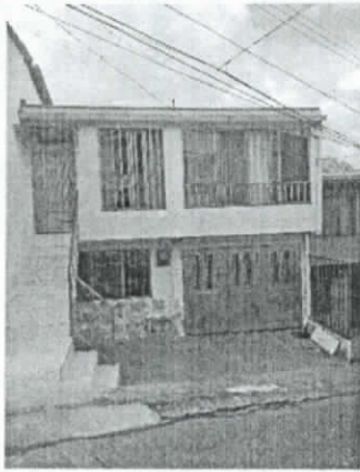
Foto No. 1 Fachada predio ubicado en la calle 65 B No. 41-19
