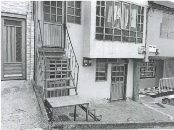
Foto No 6. Escaleras sobre andén.
