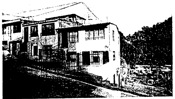
Foto No.2 Fachada actual de inmueble visitado.
