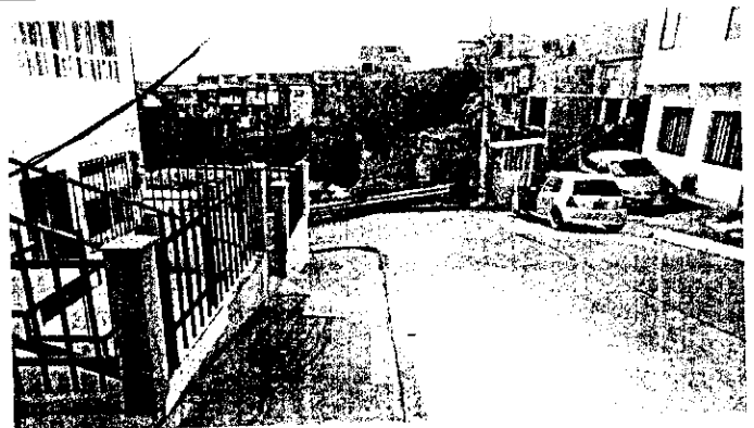
Foto No 5. Detalle de escaleras, cerramiento y endurecimiento de zona de antejardín en el inmueble.
