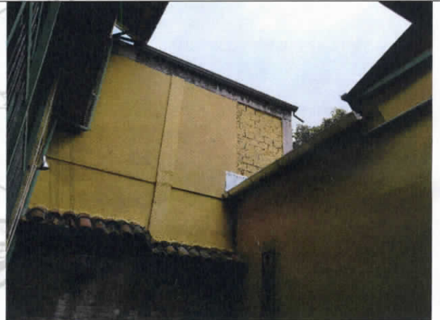
Fotografía No 24 Muros de patio en buen estado.
