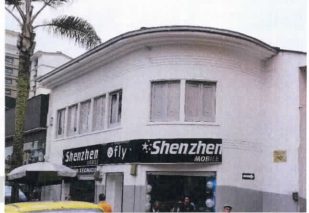
Fotografía No 4 Ventanas en buen estado sobre la carrera 23
