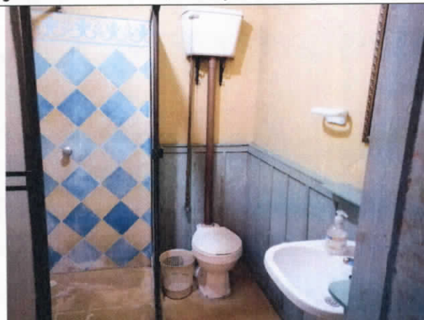
Fotografía No 15 Baño en buen estado. Nivel 2
