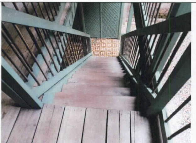
Fotografía No 22 Escaleras y chambrana en buen estado
