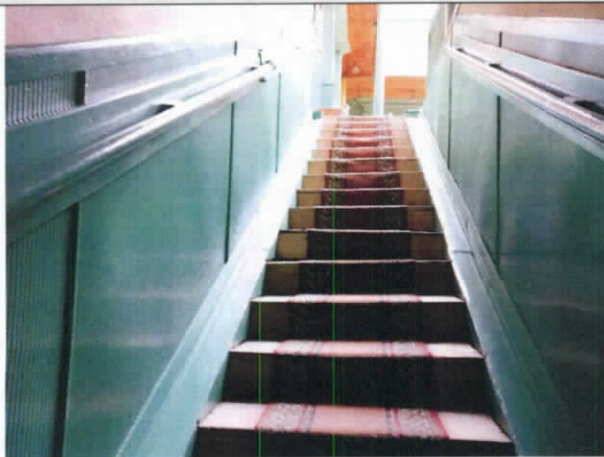
Fotografía No 9 Escaleras de acceso en buen estado
