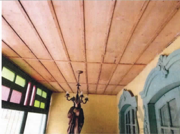
Fotografía No 23 Cielo raso en buen estado. Nivel -1
