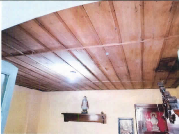
Fotografía No 19 Cielo raso en buen estado. Nivel 1
