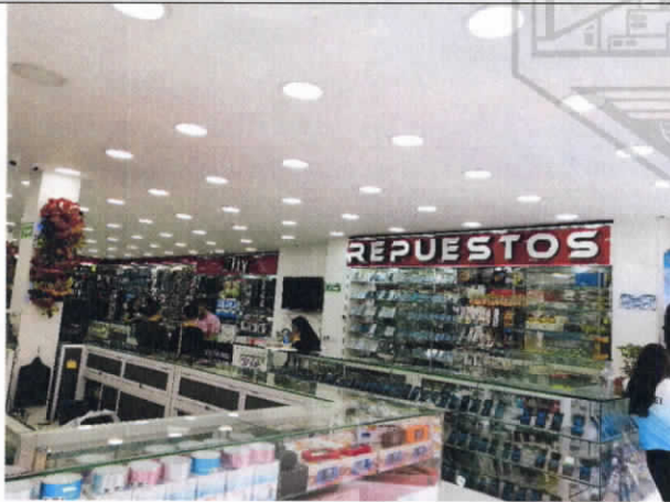
Fotografía No 5 Cielo raso y muros en buen estado “Shenzhen Mobile”
