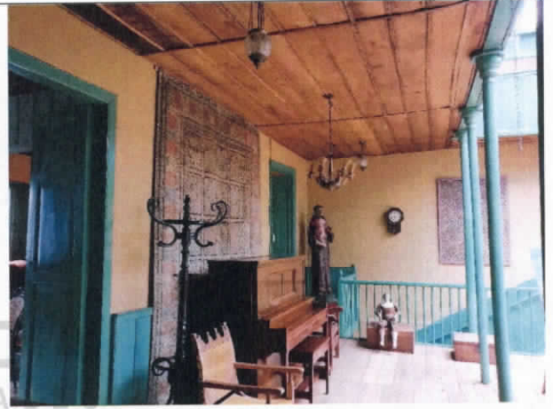
Fotografía No 12 Cielo raso y muros en buen estado. Nivel 2
