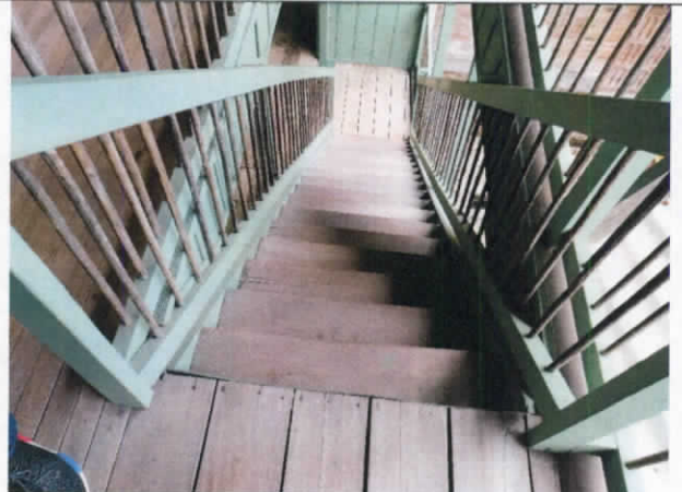
Fotografía No 18 Escaleras y chambrana en buen estado
