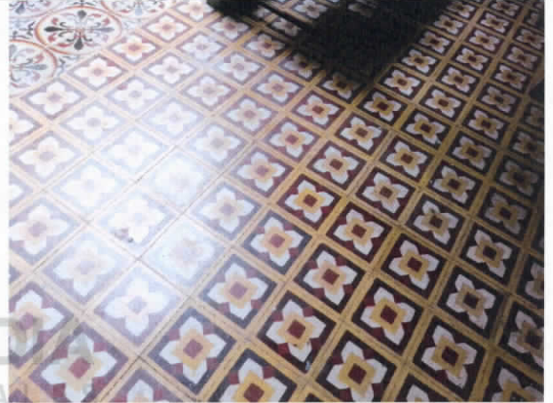
Fotografía No 24 Piso en buen estado. Nivel -1
