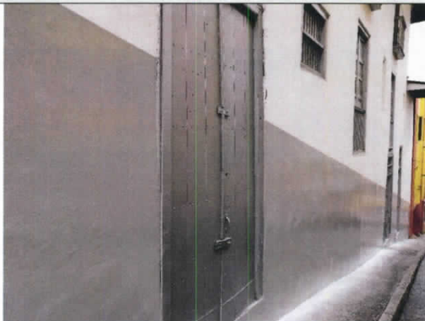
Fotografía No 1- Puertas en buen estado sobre la calle 24
