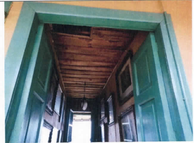
Fotografía No 16 Cielo raso y puertas en buen estado. Nivel 2
