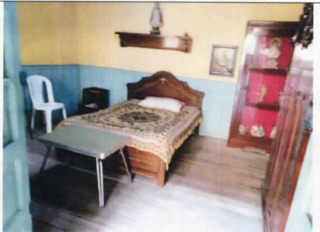
Fotografía No 20 Muros en buen estado. Nivel 1
