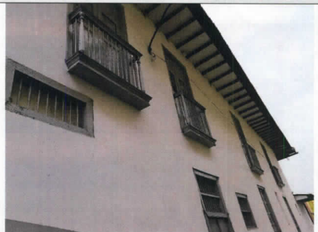
Fotografía No 2 – Ventanas en buen estado sobre la calle 24
