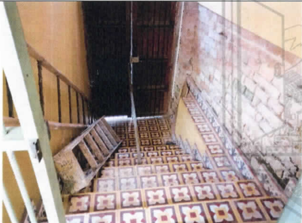
Fotografía No 25 Escaleras, muros y puerta en buen estado. Nivel -1
