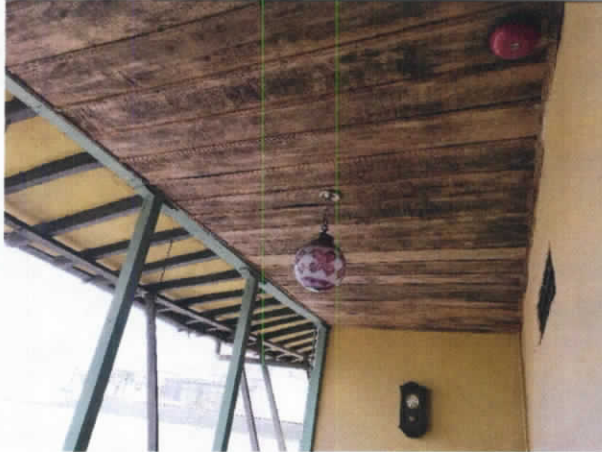
Fotografía No 17 Cielo raso y cubierta buen estado. Nivel 2
