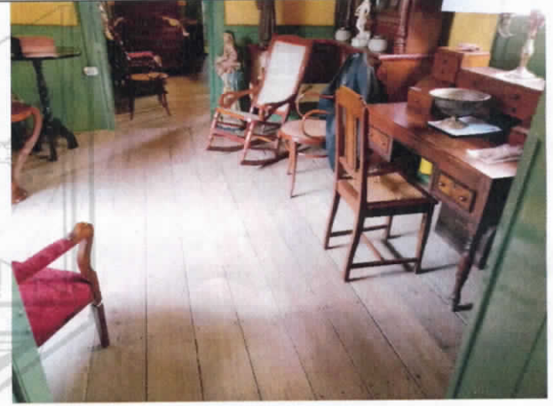
Fotografía No 14 Piso en buen estado. Nivel 2
