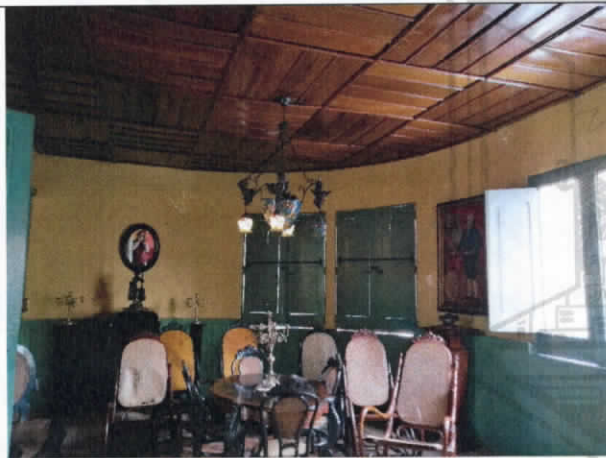
Fotografía No 13 Cielo raso, muros y ventanas en buen estado. Nivel 2
