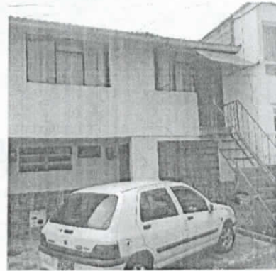
Foto No. 2 Estado actual del predio ubicado en la calle 98A No.32-14
