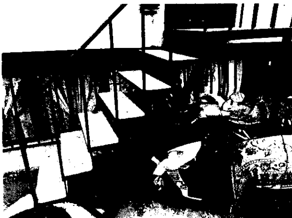
Foto No.4 Escalera sobre andén, Calle 29 No 35 09.
